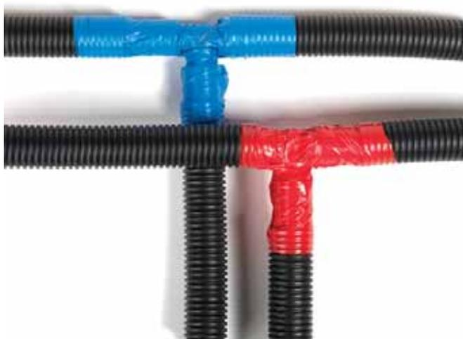
▲ Abb. 7: Verbindungsstücke bei Einbau in Boden und Mauern schützen.
